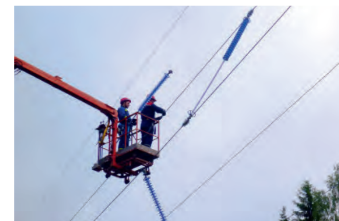
Рис. 5. Монтаж распорок РМИД на ВЛ 35 кВ в ПАО «МОЭСК»
