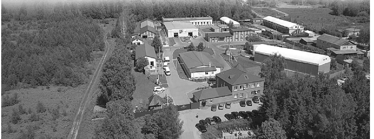
Первая производственная площадка предприятия с высоты птичьего полёта.
