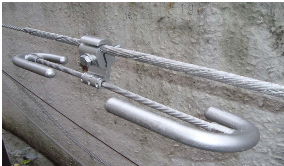
Рис. 5. Гаситель вибрации ГВ-2.4-1.6-13-550 на проводе
